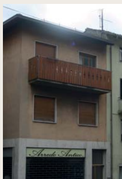
Rapporto delle finestre non conforme
