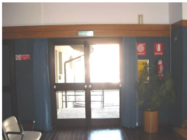
SALA CONGRESSI (piano primo): Uscita di emergenza su scala esterna di emergenza
