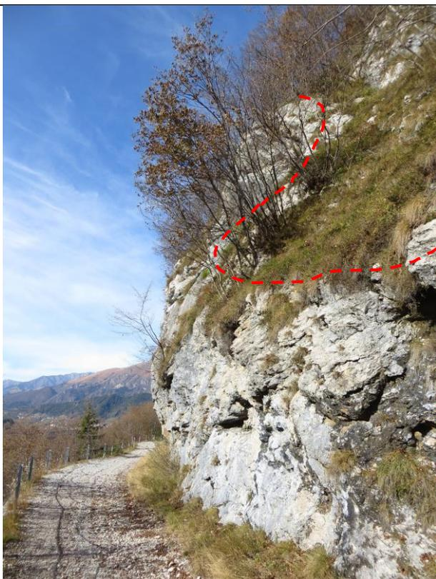
**Foto 7** – Limite del rivestimento della rete in aderenza lungo il costone roccioso (linea tratteggiata) – Vista da monte verso valle – Area di intervento B
