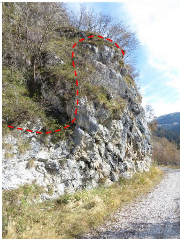
**Foto 8** – Limite del rivestimento della rete in aderenza lungo il costone roccioso (linea tratteggiata) – Vista da valle verso monte – Area di intervento B
