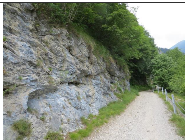
Foto 3 – Vista dell'area di intervento adiacente la strada sterrata proveniente da Via Predusolo
