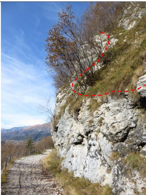
**Foto 9** – Limite del rivestimento della rete in aderenza lungo il costone roccioso (linea tratteggiata) – Vista da monte verso valle – Area di intervento B
