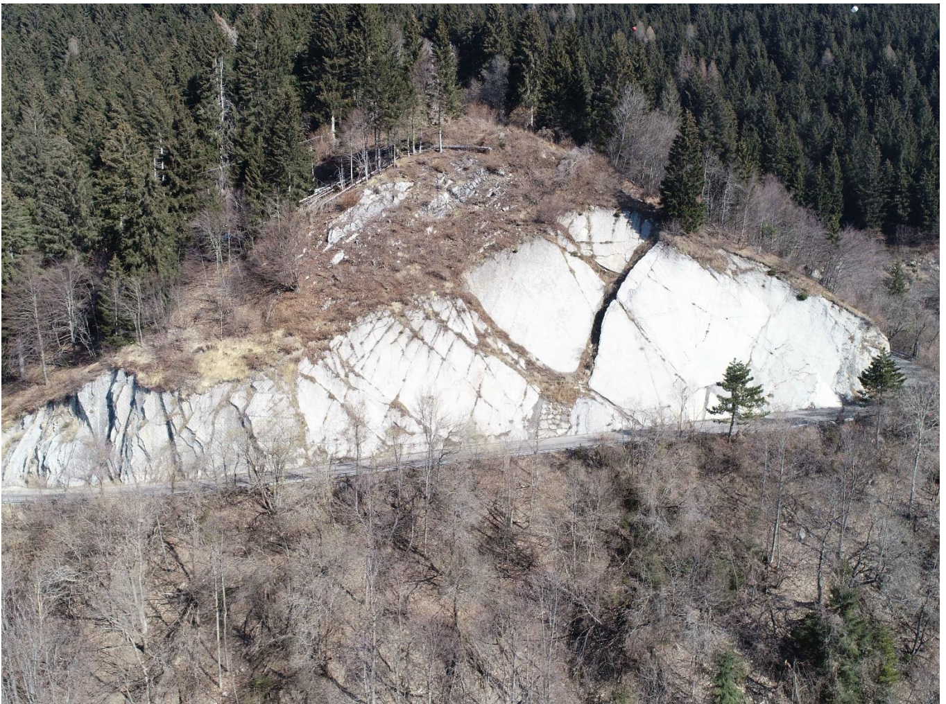
Fotografia 1: Lastre con lastre giacitura sub verticale, che hanno la possibilità di ribaltarsi, parti di questi sono stati messi in sicurezza.
