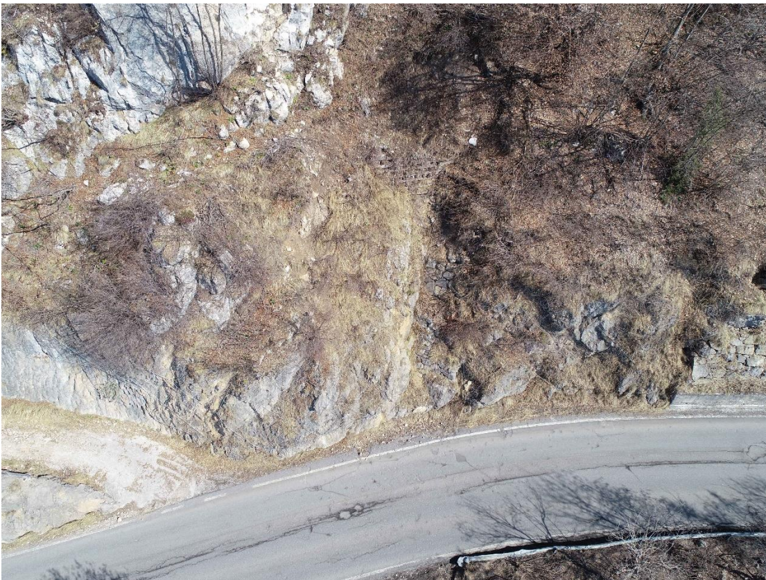
Fotografia 5: Scivolamento di materiale detritico proveniente dall'erosione delle scarpate rocciose.
