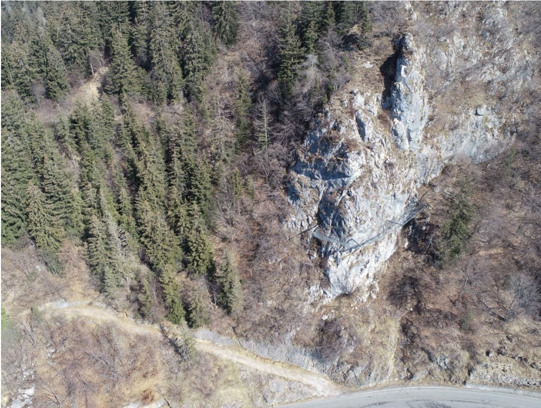
Fotografia 4: Reti già posizionate, necessita un intervento di completamento.
