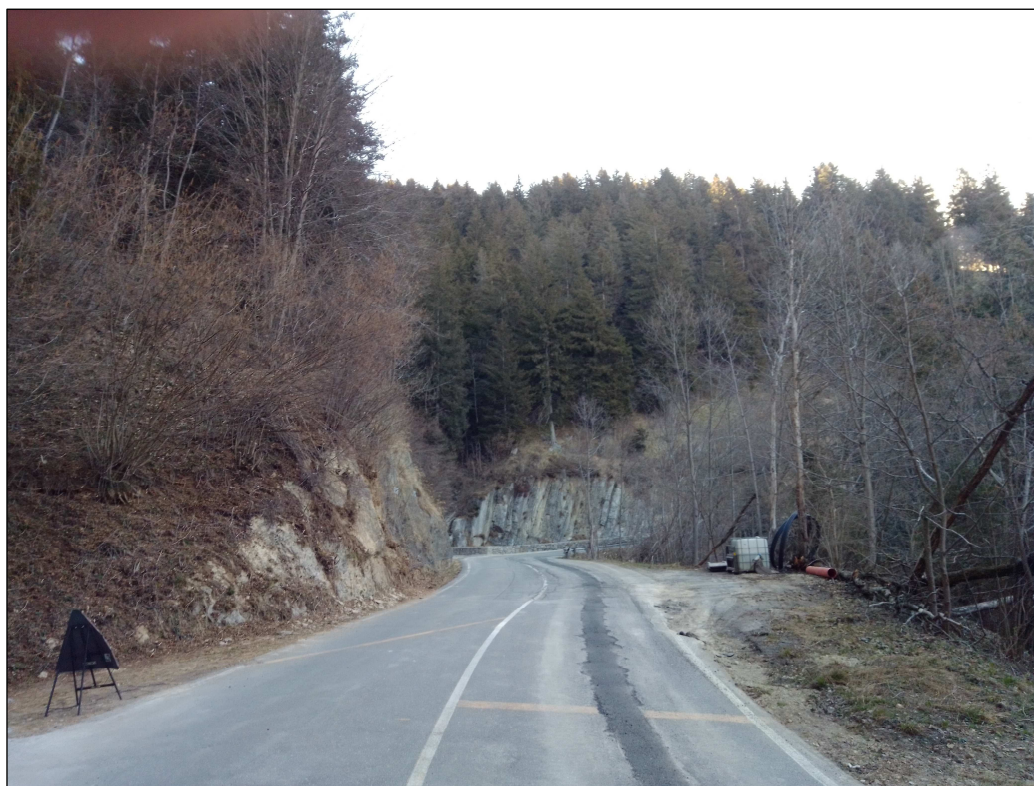
Scarpate oggetto d'intervento a monte della strada comunale per il Monte Pora
