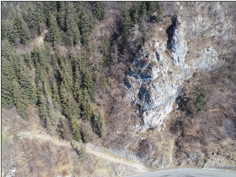
Versante con reti esistenti da sistemare e posa di nuove a completamento
