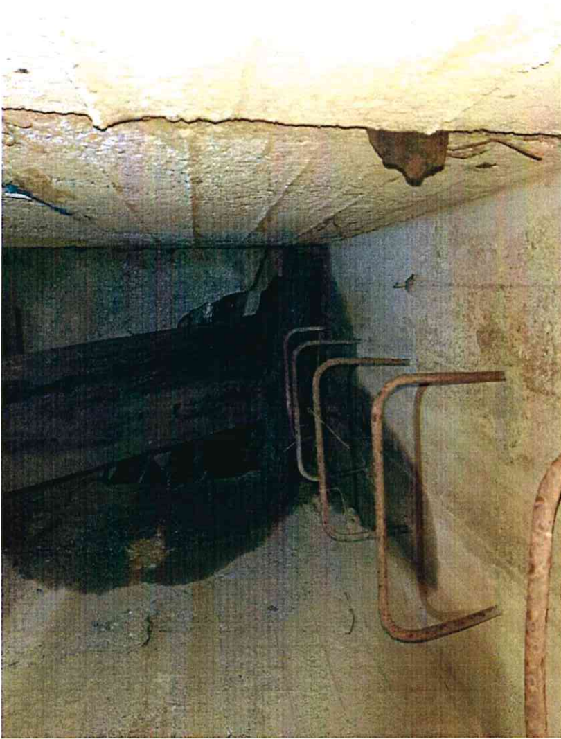
Vista cameretta dal sotto (operatore ha fatto accesso dal tubo)
