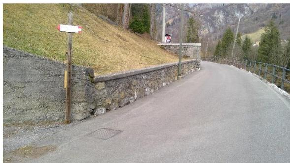
Proseguendo oltre lungo la strada, la scarpata di monte è sostenuta da muri in pietrame: quello antistante il mappale 10730 in pietrame e calcestruzzo di realizzazione abbastanza recente; quello sul mappale 10920 è invece un vecchio muro in pietrame a secco. In prossimità dei già menzionati mappali 10730 e 10920 la scarpata a monte dei muri è di lieve pendenza.
