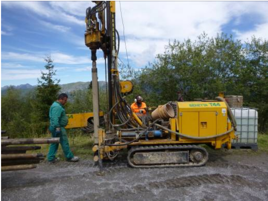
Ubicazione sondaggio S 1
