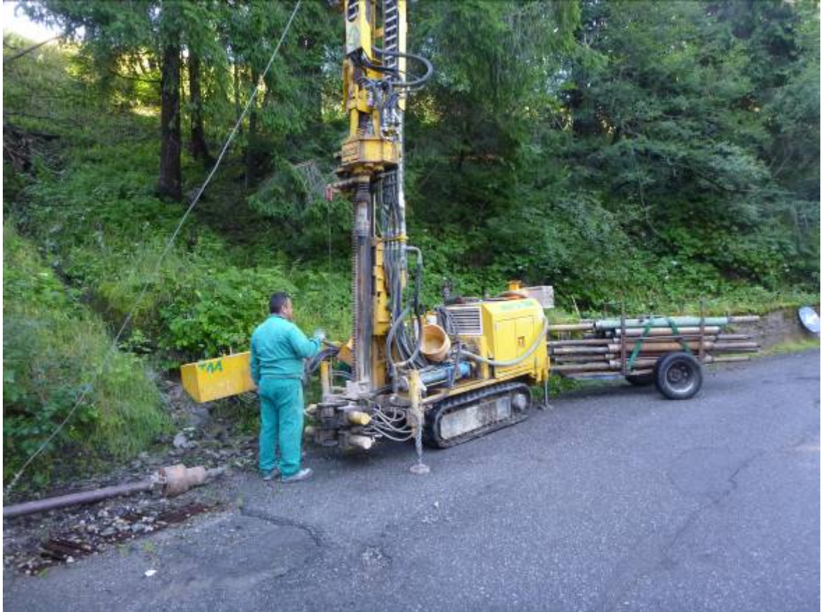
Ubicazione sondaggio S 3
