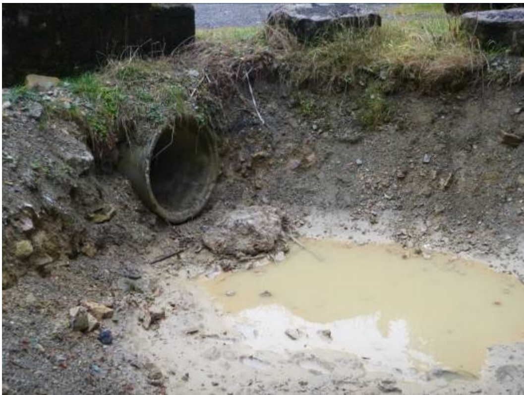
Particolare vasca di sedimentazione parcheggio P 5
