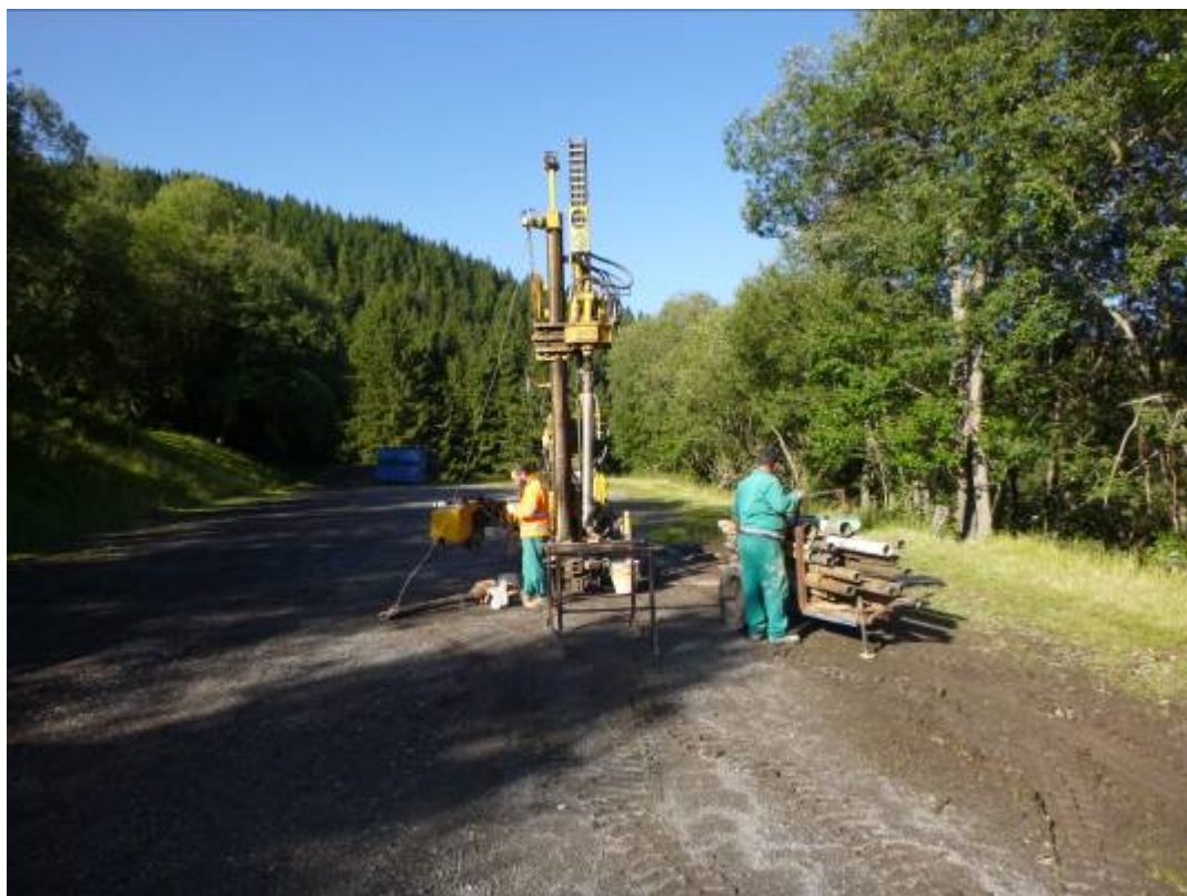
Ubicazione sondaggio S 2
